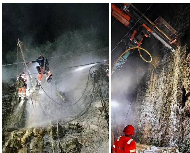
En haut : travaux de forage dans les murs de parement (Prona : 08.04.2024)
